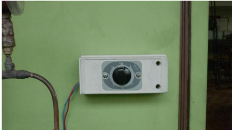
FIGURA 55. INSTALACION DEL TERMOSTATO
