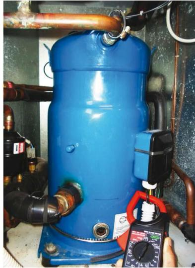
**FIGURA 41. MEDICIÓN DE CORRIENTE EN LA ENTRADA DEL COMPRESOR.**
