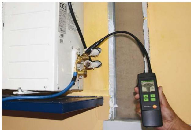
FIGURA 31 DETECCIÓN DE FUGAS EMPLEANDO DETECTOR ELECTRÓNICO
