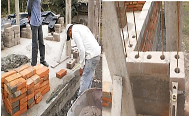
**Foto N°12: Vista de la Vivienda en su fase de terminación de pegado de ladrillo de tierra cemento.**
