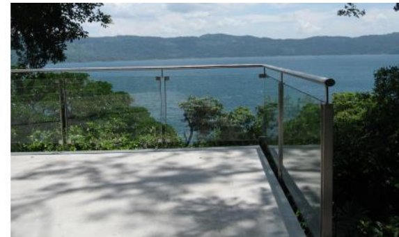
Imagen #59 acceso con vidrio templado con aplicación sandblasting
