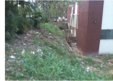
Imagen # 12 Área del talud contiguo al auditorium
