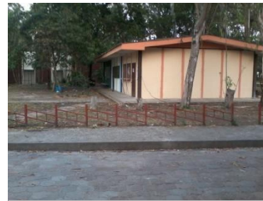
Imagen # 13 Área oeste del terreno
