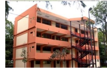
Imagen # 7 Edificios De Aulas B,C,D
