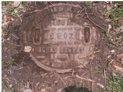
Imagen # 20 Pozo de aguas negras N°36
