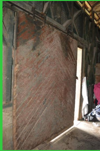
Vista de puerta 4 interior
