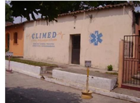
Figura 49 Clínica médica particular sobre la avenida Delgado. Fuente: Elaboración Propia
