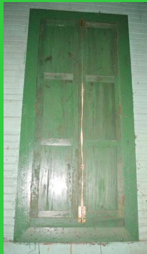
Vista de puerta 5 interior
