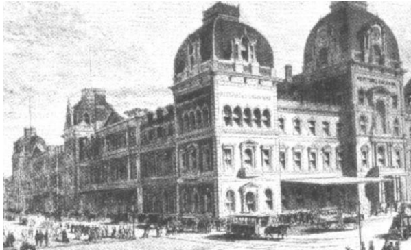
Figura 32 Estación Grand Central II en Nueva York. Fuente: Historia de las Tipologías Arquitectónicas
