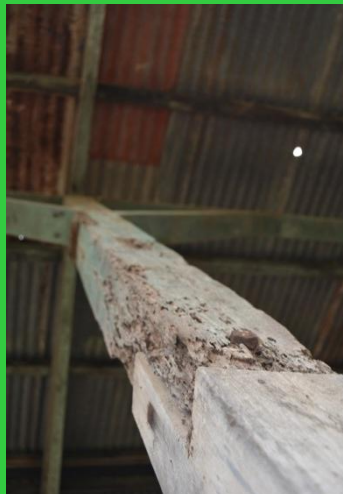
Vista de columna 7 (Se puede apreciar la estructura altamente dañada por xilófagos)
