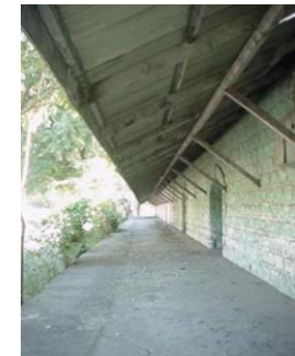
Figura 8 Pasillo Lateral, San Miguel. Fuente: Tesis “Valorización de la arquitectura Ferroviaria en el salvador”
