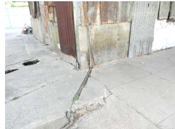
Figura 65 Tubería de agua potable agregada recientemente. Fuente: Elaboración Propia
