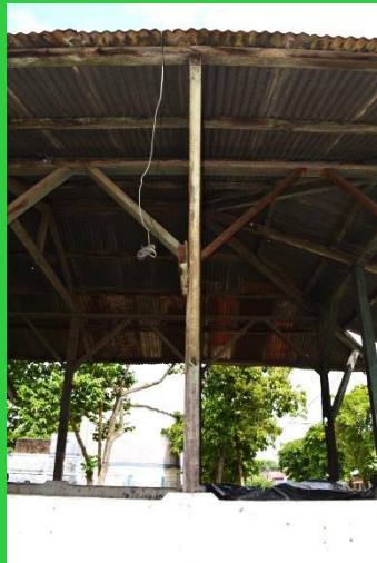
Vista de columna 2
