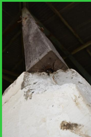
Vista de base de apoyo de columna
