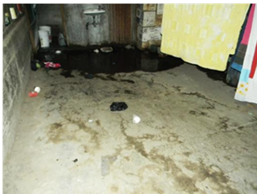
Figura 66 Vista interior de servicio sanitario. Fuente: Elaboración Propia
