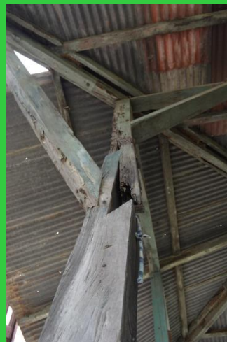
Vista de columna 5 (puede apreciarse la gravedad de la grieta)
