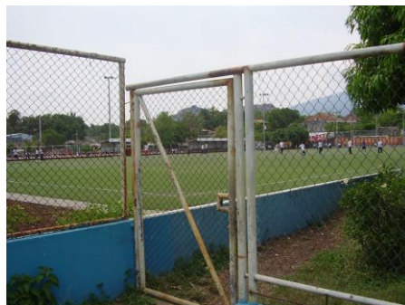
Figura 52 Cancha El Lirio, Ubicada en la comunidad con el mismo nombre al sur de la estación ferroviaria. Fuente: Elaboración Propia
