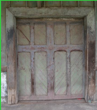
Vista de puerta 5 exterior
