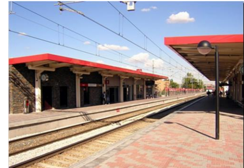
Figura 88 Área de abordaje de la estación de Aravaca en Madrid España. Fuente: Portal web Metro Madrid
