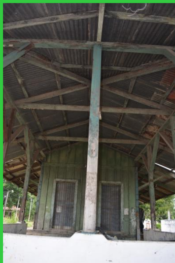
Vista de columna 4
