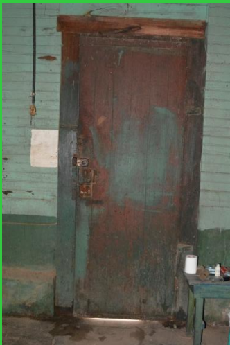
Vista de puerta 2 interior
