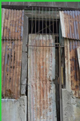
Vista de ventana 9 exterior
