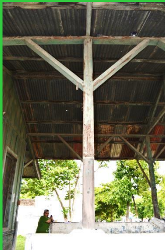
Vista de columna 1 (Se puede apreciar la grave erosión por xilófagos)
