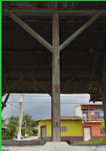
Vista de columna 7 (Se puede apreciar la estructura altamente dañada por xilófagos)
