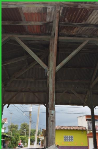
Vista de columna 6
