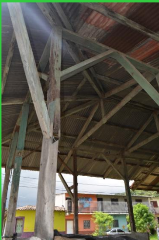
Vista de columna 5 (puede apreciarse la gravedad de la grieta)
