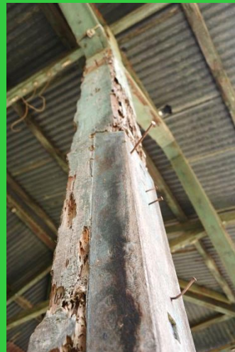
Vista de columna 1 (Se puede apreciar la grave erosión por xilófagos)
