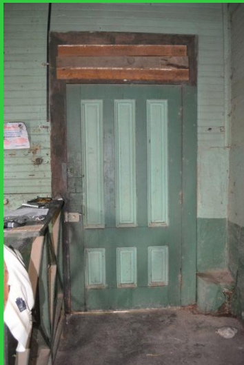
Vista de puerta 1 interior
