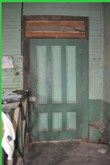
Vista de puerta 1 interior
