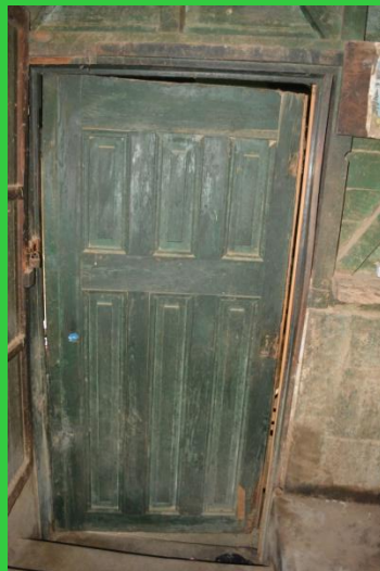
Vista de puerta 3 interior
