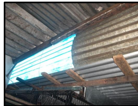
Imagen 18. Uso de lamina translucida para dar paso a la luz solar
