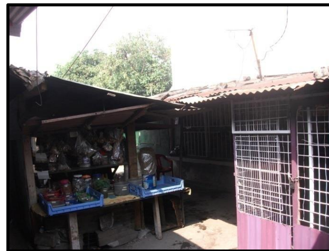
Imagen 19. Discontinuidad en pasillos en el interior del mercado.
