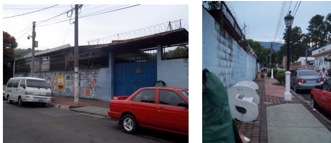
Imagen 43: Mobiliario Eléctrico de la zona
