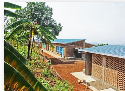
Imagen 56: Vista de edificaciones de aulas
