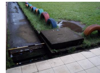
Imagen 26: pozo resumidero para aguas lluvias
