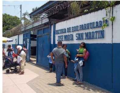
Imagen 9: Fachada principal de Parvularia José María San Martín
