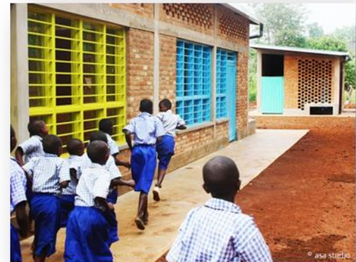
Imagen 55: Vista exterior de aulas
