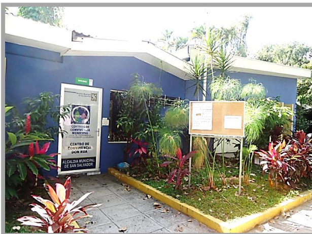
FOTO 26: Fachada principal oficina administrativa.
