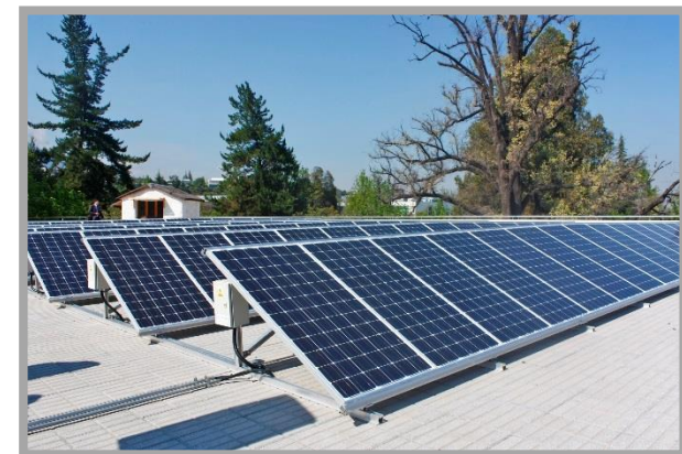
FOTO75: Paneles solares monocristalinos.
