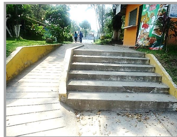
FOTO 6: Rampa y gradas de acceso al área de piscinas.
