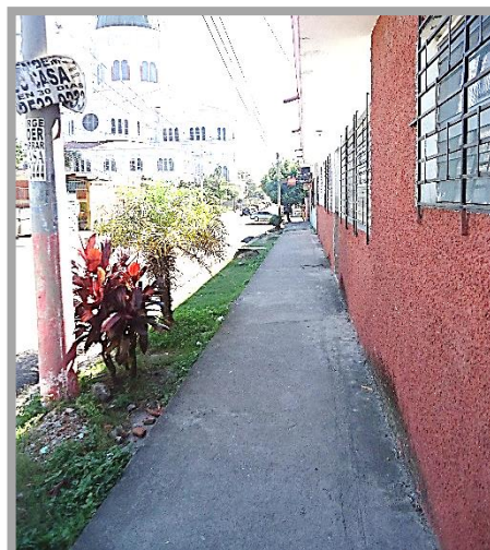
FOTO 61: Acera en buen estado sobre la 23 Calle Poniente.
