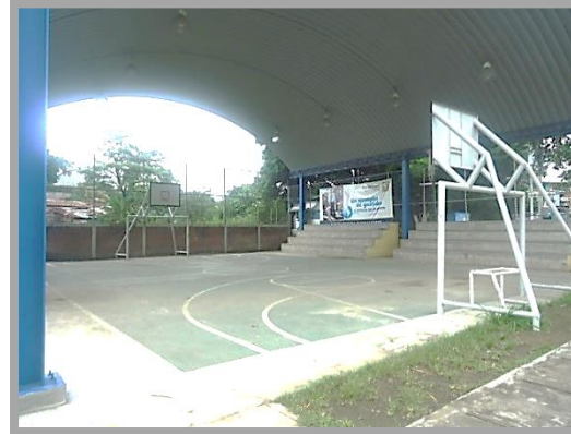
FOTO 68: Cancha de BKB techada.
