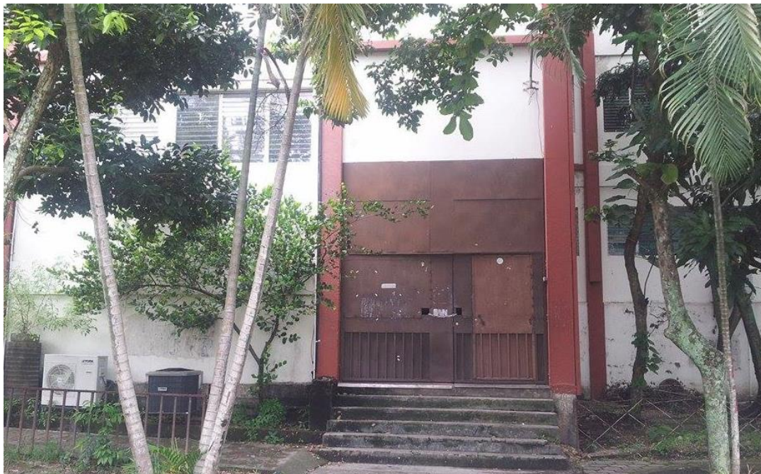
Fotografía 1: Fachada Norte del Edificio 1.
