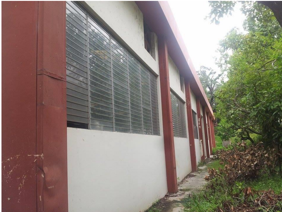
Fotografía 4: Fachada Sur del Edificio 2.
