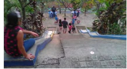
Imagen N° 56: Deslizaderos conformados en los taludes
