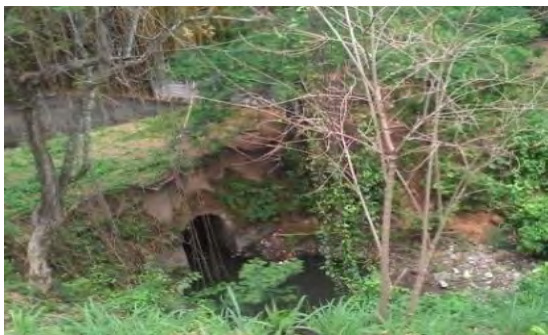
Imagen N°13: Obras de Mitigación
