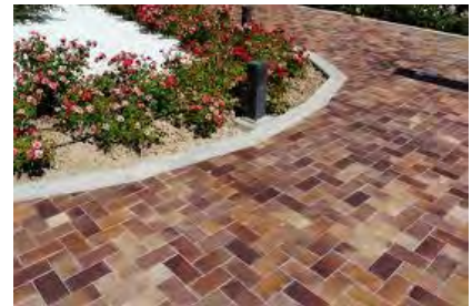
Imagen N° 49: Pavimento de adoquín
