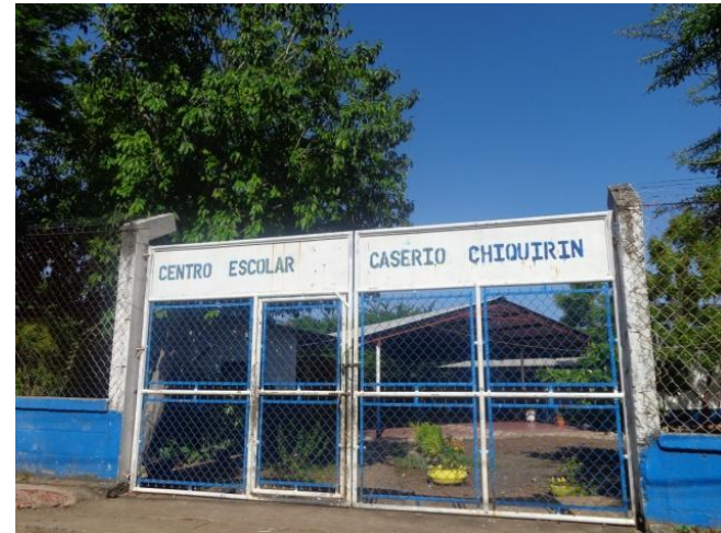
FOTOGRAFÍA 6: Centro Escolar “Caserío Chiquirín”, en Cantón Punta Chiquirín.
