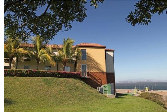
FIGURA 95: Instalaciones de descanso Hotel Confort
