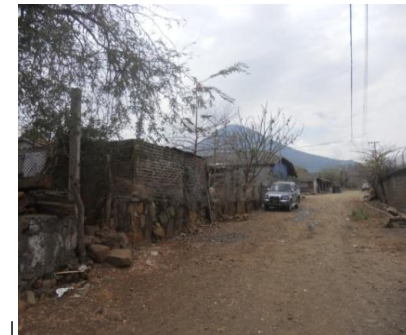
FIGURA 86: Calle balastrada hacia cantón Chiquirín
