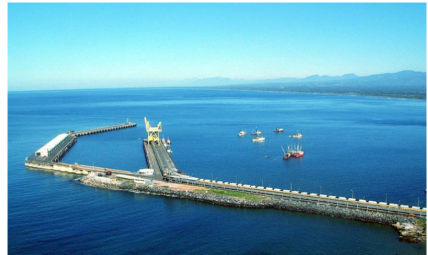
FIGURA 4: vista aérea del nuevo muelle de el puerto de Cutuco, CEPA, 2014. (Fuente: El Salvador.com)
