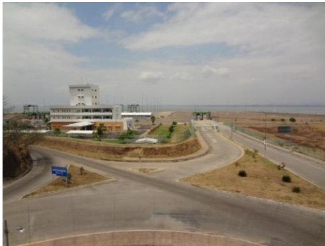
FIGURA 91: Instalaciones del Puerto Cutuco
