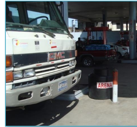
Ilustración 2.126. Protectores de Impacto Incompletos.
