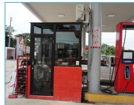
Ilustración 2.14. Caseta de Cobro en Pista.
