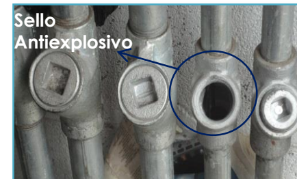
Ilustración 2.41. Conductos eléctricos antiexplosivos.
