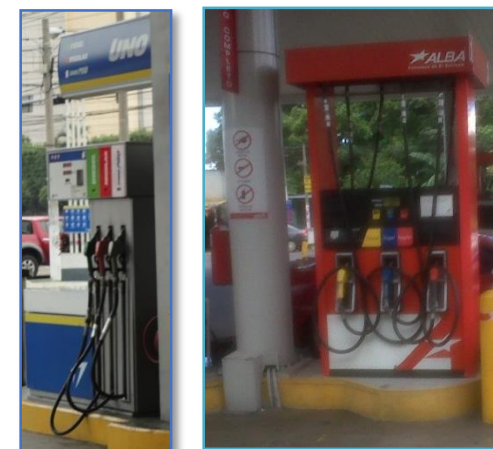
Ilustración 2.11. Dispensadores de 6 mangueras.
