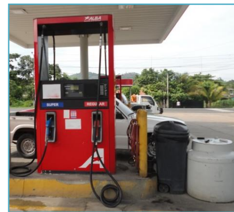
Ilustración 2.10. Dispensador de 4 mangueras.
