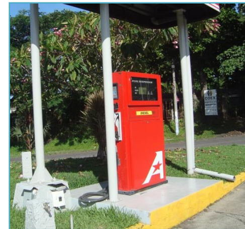
Ilustración 2.13. Dispensador para Flujo rápido.
