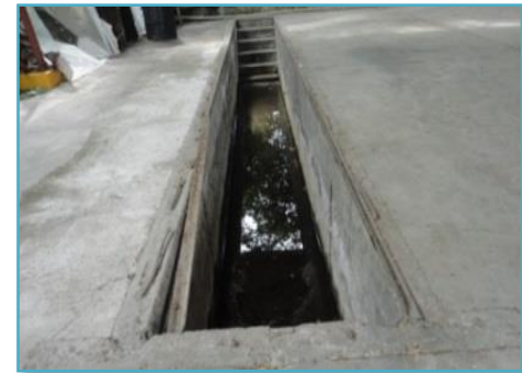
Ilustración 2.71. Fosa para cambio de aceite.
