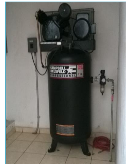
Ilustración 2.39. Compresor de Aire.
