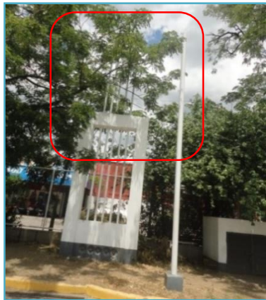
Ilustración 2.127. Tubería de venteo obstruida por árbol.
