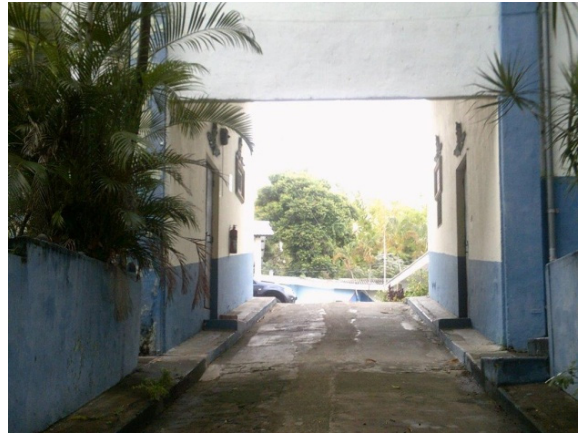
Fotografía 12 Acceso N°2 desde calle Francisco Menéndez
