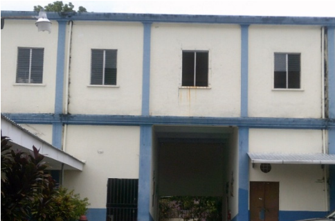
Fotografía: Acceso sobre calle Francisco Menéndez, por el momento deshabilitado y edificio con patrimonio cultural a conservar y rehabilitar.
