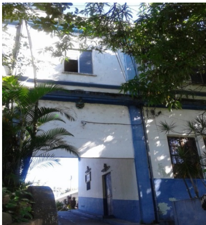
Fotografía 13. vista de estado actual de la fachada principal de edificio
