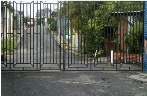
Fotografía: Acceso Principal existente sobre el Pasaje Galán, no posee las condiciones espaciales adecuadas, para el ingreso de los camiones de rescate que se utilizan para las emergencias.
