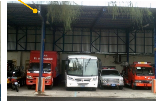
Fotografía Parqueo y taller para los camiones, Cuenta con el espacio necesario para el desarrollo de las actividades que se realizan. Aunque este tienen un difícil acceso a la hora de atender una emergencia.
