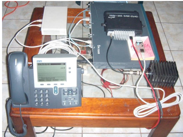
Figura 49. Montaje de los elementos que intervienen.
