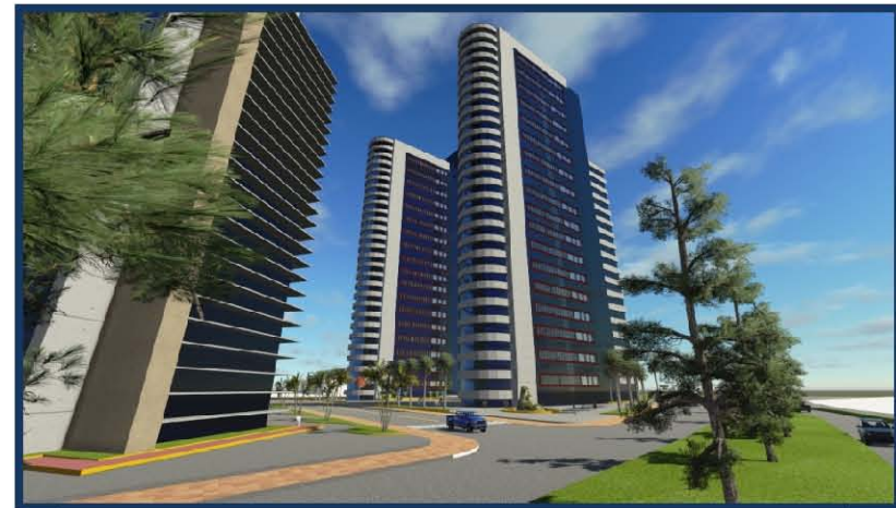
Fig. 173 Vista Sur poniente del Edificio Financiero
