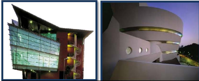
Fig.162 Detalles en vidriera y geometría distorsionada del High Tech y curvaturas y sinuosidades geométricas del organismo.
