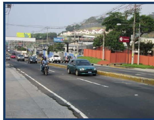
Fig.96 Foto actual Carretera al Puerto de la Libertad.
