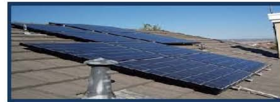
Fig. 138 Implementación de paneles solares en techos
