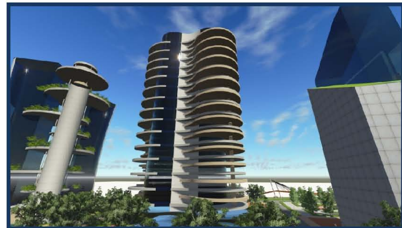
Fig. 177 Vista de fachada Norte del Edificio Habitacional
