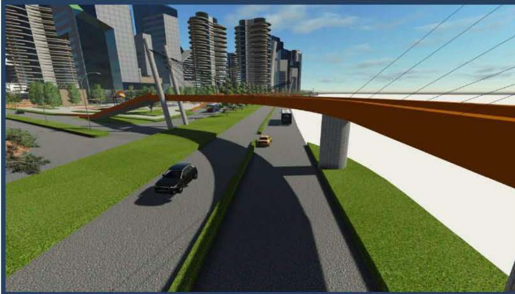
Fig. 233 Paso a desnivel desde Carretera al Puerto de la Libertad lado poniente hacia Zona de Proyectos
