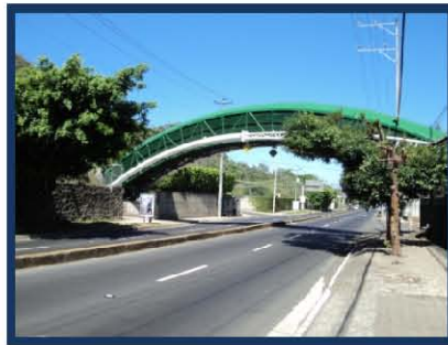
Fig.20 Imagen actual de Boulevard Sur.
