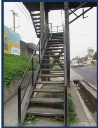
Fig. 125 Ubicación de puentes peatonales en puntos críticos.
