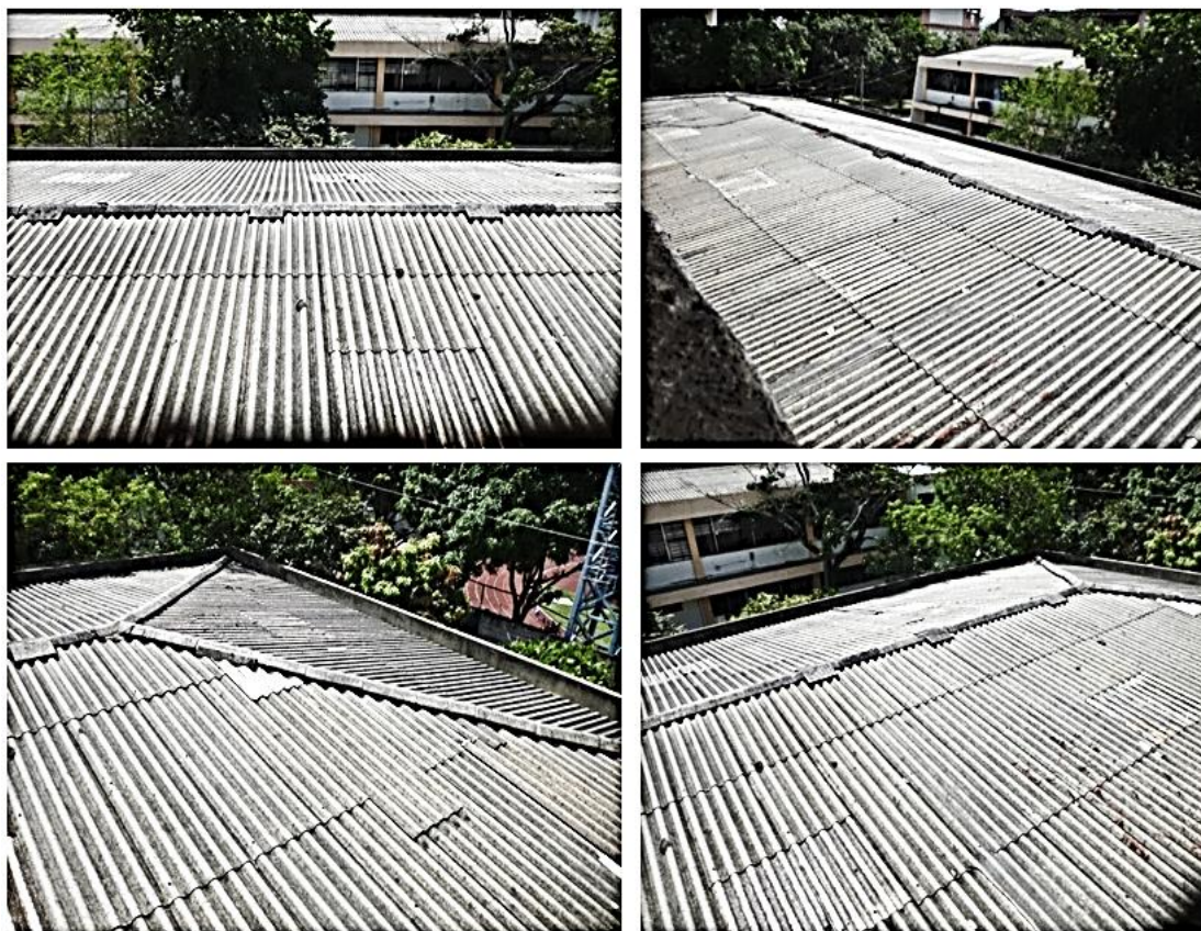
Fig. 2.22. Fotografías del aspecto del techo de la Unidad Productiva y del Taller de Motores a las 12:00 M en noviembre.
