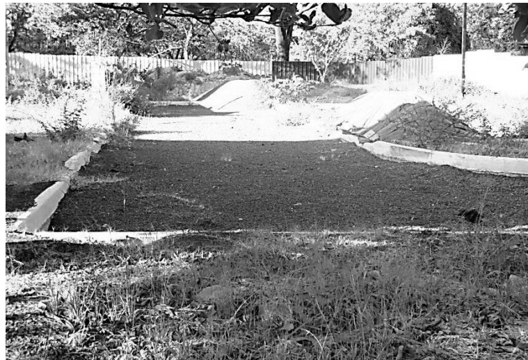
Figura A-7.2. La zona verde considerada como una alternativa para la instalación de la planta piloto de energía solar térmica está en construcción para un estacionamiento.
