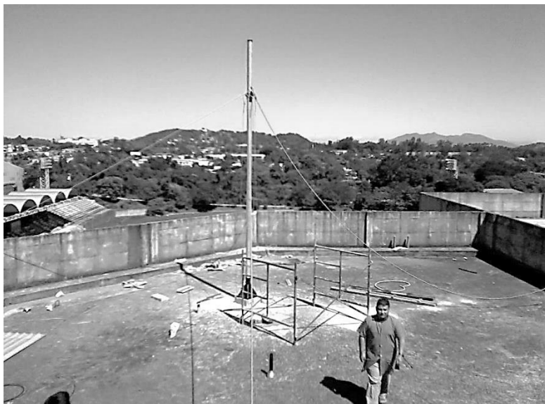
Fig. A-6.2. El espacio en la azotea de la biblioteca de la Facultad de Ingeniería y Arquitectura de la UES es reducido debido a otros proyectos de energía renovable que se están desarrollando en el lugar.
