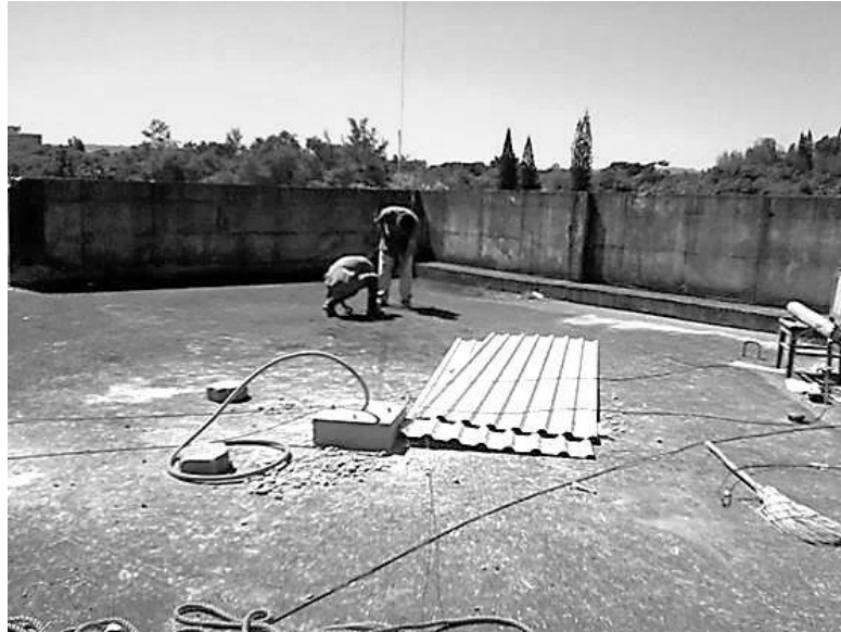
Fig. A-6.1. Trabajos que se realizan en la azotea de la biblioteca de la Facultad de Ingeniería y Arquitectura de la UES en 2013.
