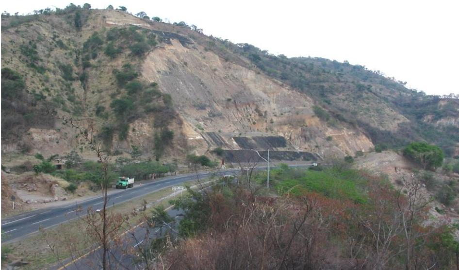
b) Daño erosivos en los taludes de la Curva de la Leona.
