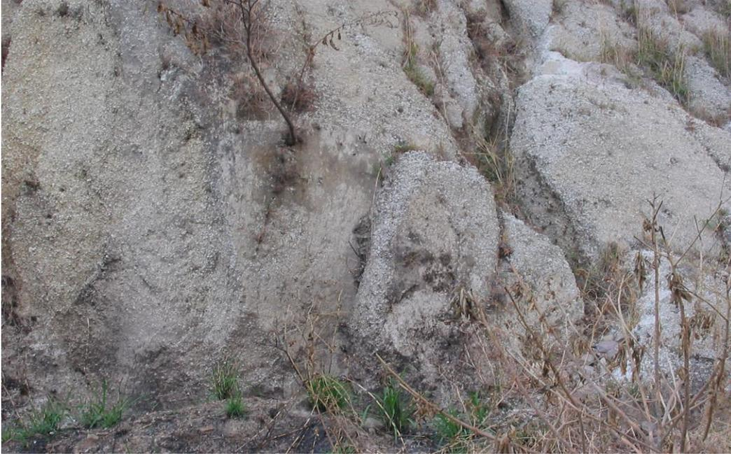
b) Talud dañado por erosión en surco.
