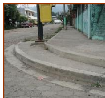
Fotografía III-25: Discontinuidad en acera, inexistencia de rampa (3ª Calle Poniente).
