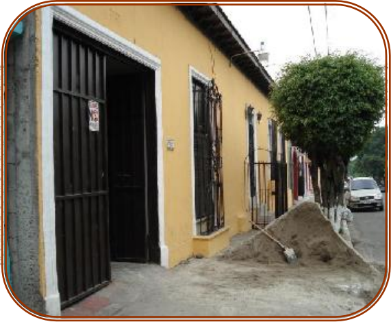
Plataforma con barandilla (defensas).
