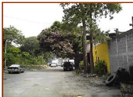
Fotografía III-31: 16ª Avenida Norte sin recubrimiento.
