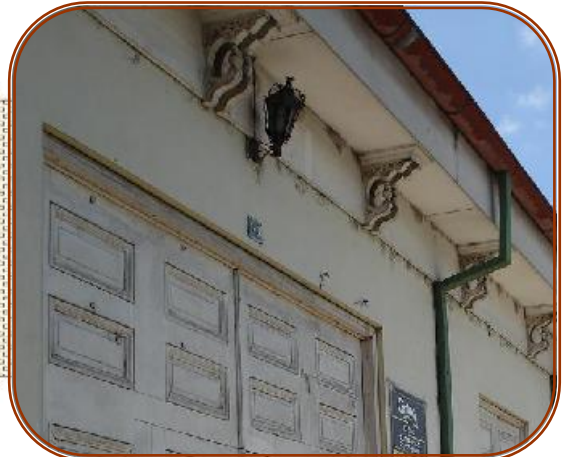
Ménsula sosteniendo alero.
