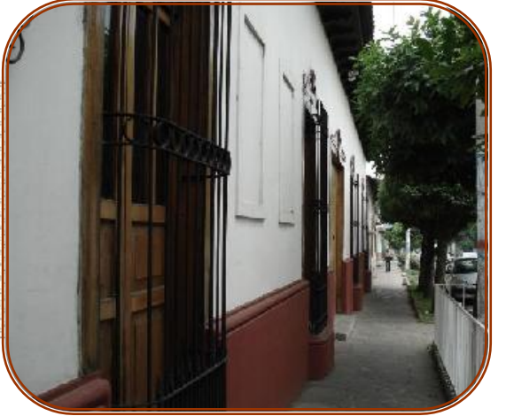
Plataforma con barandilla (defensas).
