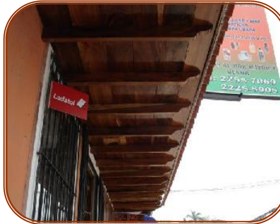
Alero sostenido por ménsulas.
