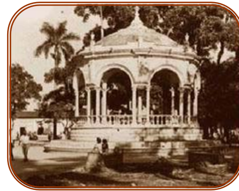
Kiosco del Parque Hernández en su época de gloria, construido en 1912.
