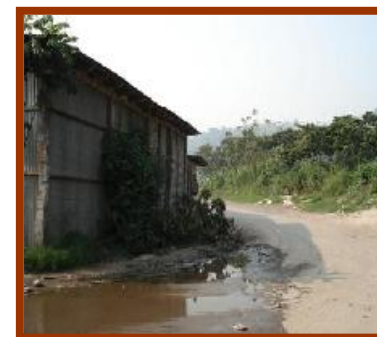
Fotografía III-21: Agua sobre 16ª Av. Norte
