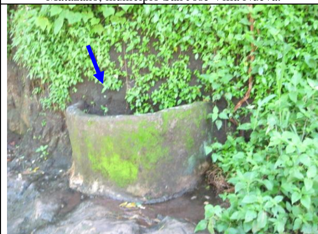
Manantial La Pila, comunidad Santa María, cantón Las Dispensas, municipio Sal José Villa Nueva.
