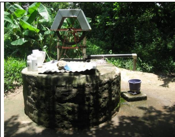
Pozo protegido, comunidad Tepeagua, cantón Tepeagua, municipio La Libertad.
