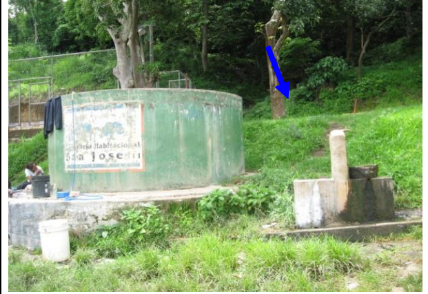
Manantial El Tanque, comunidad Complejo San José No. 2, cantón Tula, municipio San José Villa Nueva.
