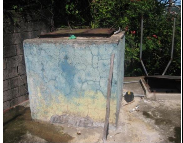
Clorador Tanque Mirapueblos, cantón Nuevo Cuscatlán, municipio Nuevo Cuscatlán.
