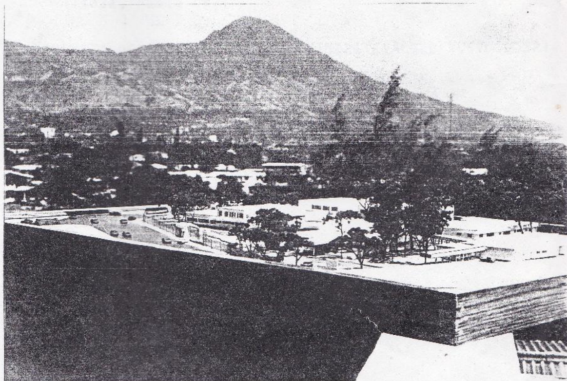
VISTA DEL SUR - ORIENTE DEL CONJUNTO
