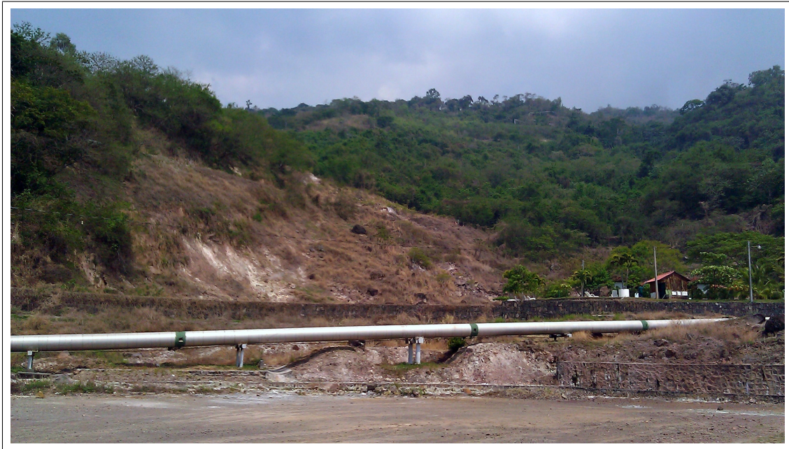
Figura 1.16: Vista panorámica del deslizamiento Sur de la Plataforma del Pozo TR-7 del Campo Geotérmico de Berlín.
