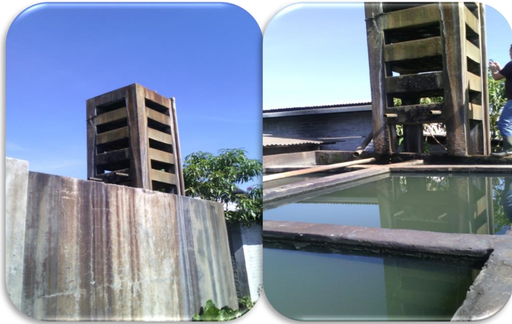
Figura Nº 36. Torre de filtración del agua para bebida animal, Hacienda El Conacaste, con solo apreciar el color de las paredes del tanque de almacenamiento se puede tener una idea de la cantidad de hierro que poseen estas aguas
