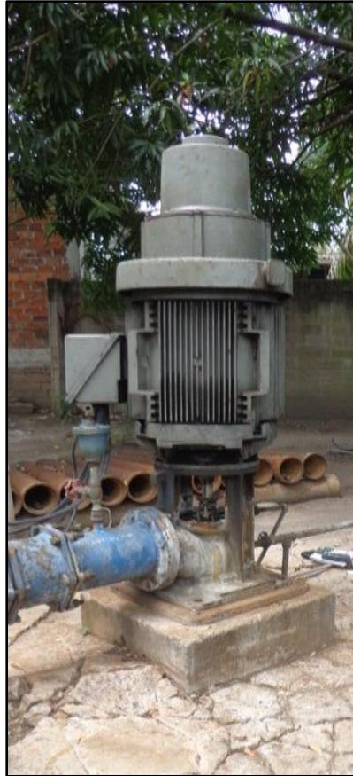
*Figura 30 Motor eléctrico vertical de eje hueco General Electric, 150Hp en funcionamiento en estación de bombeo La Sultana.*
