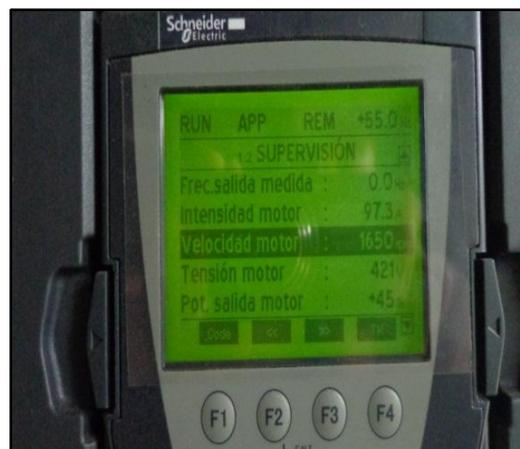
*Figura 29 Terminal grafico de variador de velocidad Schneider Altivar 61.*
