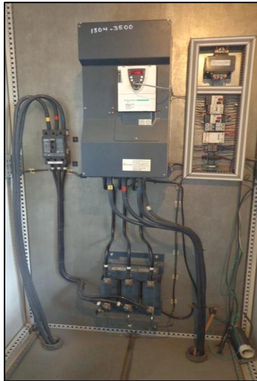
*Figura 28 Interior de gabinete de variador de velocidad Schneider Altivar 61.*
