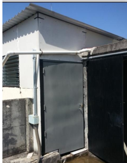
Figura A. 2: a) Sellado completo de una pared con tabla roca. b) Colocación de puerta de acceso al Laboratorio [46]
