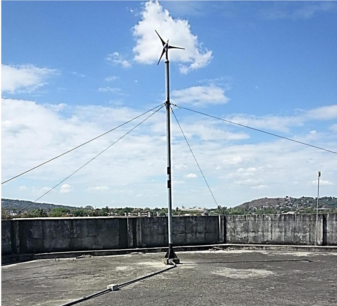
Figura 105: Instalación del aerogenerador sobre mástil, con una altura efectiva desde el nivel suelo de 11.5 m. [46]
