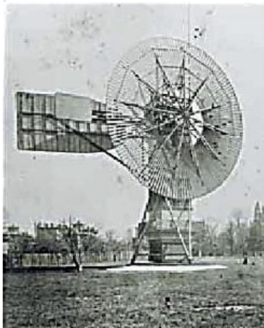
Figura 44: a) Turbina eólica (Charles Brush). b) Aerogenerador (Paul la Cour). [20]
