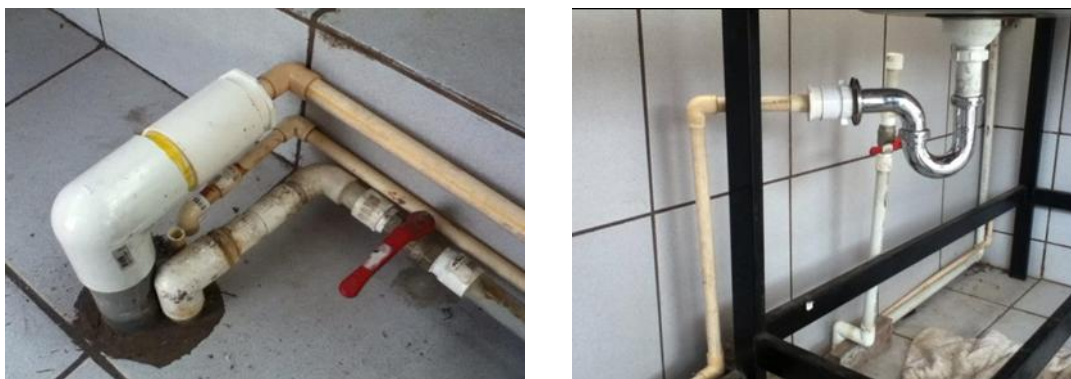
Figura A. 6: Colocación de la Tubería para el paso de agua en el Laboratorio. [46]
