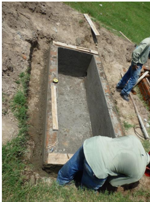
Figura 18. Construcción de los humedales: Impermeabilización de la unidad.
