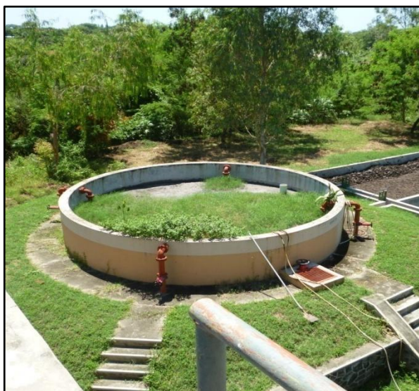
Figura 10. Digestor de lodos de la PTAR de San Luis Talpa.
