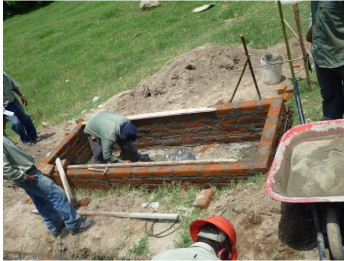
Figura 17. Construcción de los humedales: Materiales utilizados.
