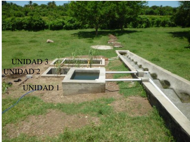
Figura 13. Unidades de las que estaba compuesto el humedal artificial secuencial.
