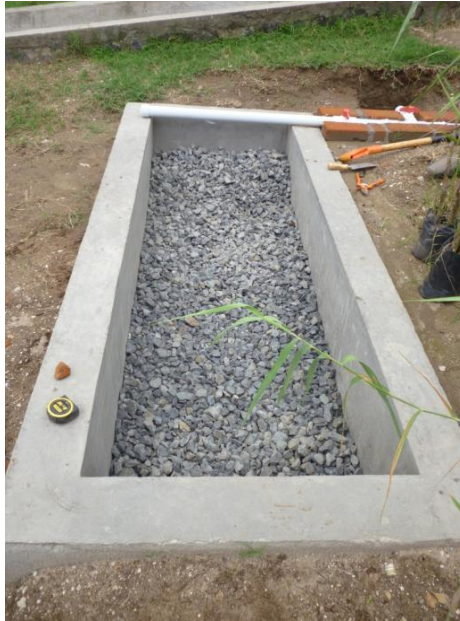
Figura 14. Disposición de la grava utilizada como sustrato en el humedal artificial cultivado con Phragmites australis .
