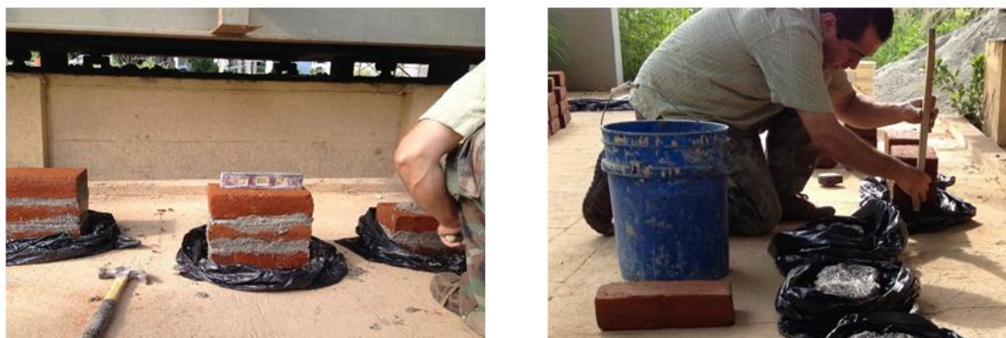
Fig. 3.9 – Nivelación y alineación de los prismas.
