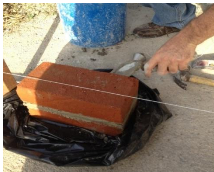
Fig. 3.8 – Colocación de la segunda hilada.
