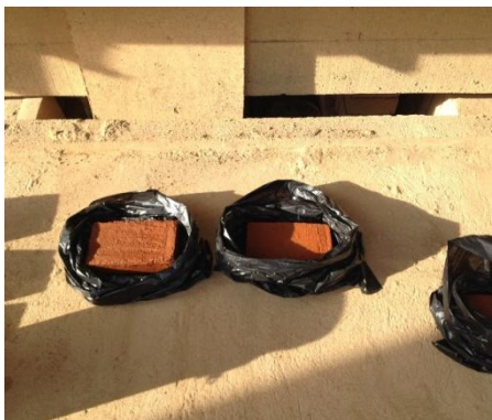
Fig. 3.7 – Colocación de la primera hilada.
