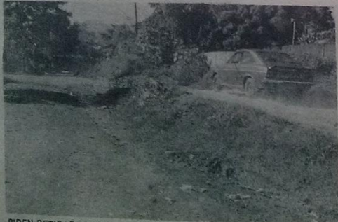
PIDEN RETIRAR PROMONTORIOS DE TIERRA Y PIEDRA. - Habitantes de las colonias Bosques del Matazano, San Cayetano y Venecia ubicadas al Sur de Soyapango ruegan al Ministerio de Obras Públicas (MOP), retire promontorios de tierra y piedra que están desde hace cinco años sobre la calle pavimentada El Matazano que hoy más parece una quebrada. Estos volcanes de tierra y piedra son producto de las corrientes que bajan del cerro San Jacinto en época de invierno lo cual podría originar una tragedia en este populoso sector.
