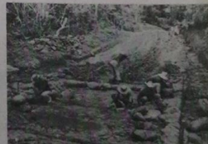
CONSTRUCCION VIA DE ACCESO Los habitantes del Cantón La Laguna, J/San Carlos pusieron ¡Manos a la Obra! y ya están construyendo su vía de acceso, en beneficio de toda la comunidad.
