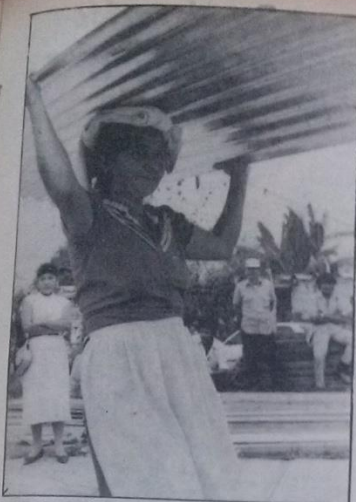
RECONSTRUYE VIVIENDA. Un habitante de la colonia Santa Marta 2 carga una lámina, para reconstruir su vivienda dañada por la embestida terrorista del FMLN-FDR. El alcalde capitalino, Dr. Armando Calderón Sol, entregó materiales de construcción ayer.
