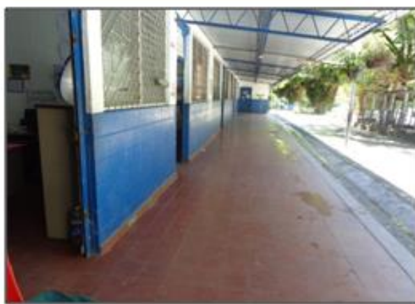
Area del pabellón, donde se puede apreciar que no han sufrido ningún tipo de modificación
