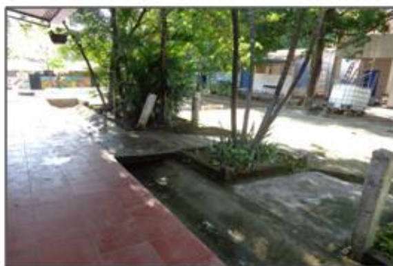
Área inadecuada para estudiantes con NEE
