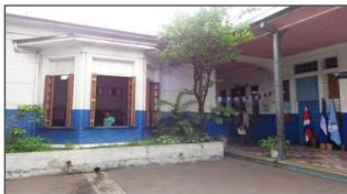
Área inadecuada para estudiantes con NEE
