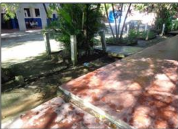
Área inadecuada para estudiantes con NEE
