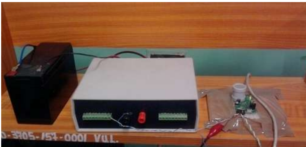
Fig IV.5 Dispositivos de medición instalados en la estación SAF01.
