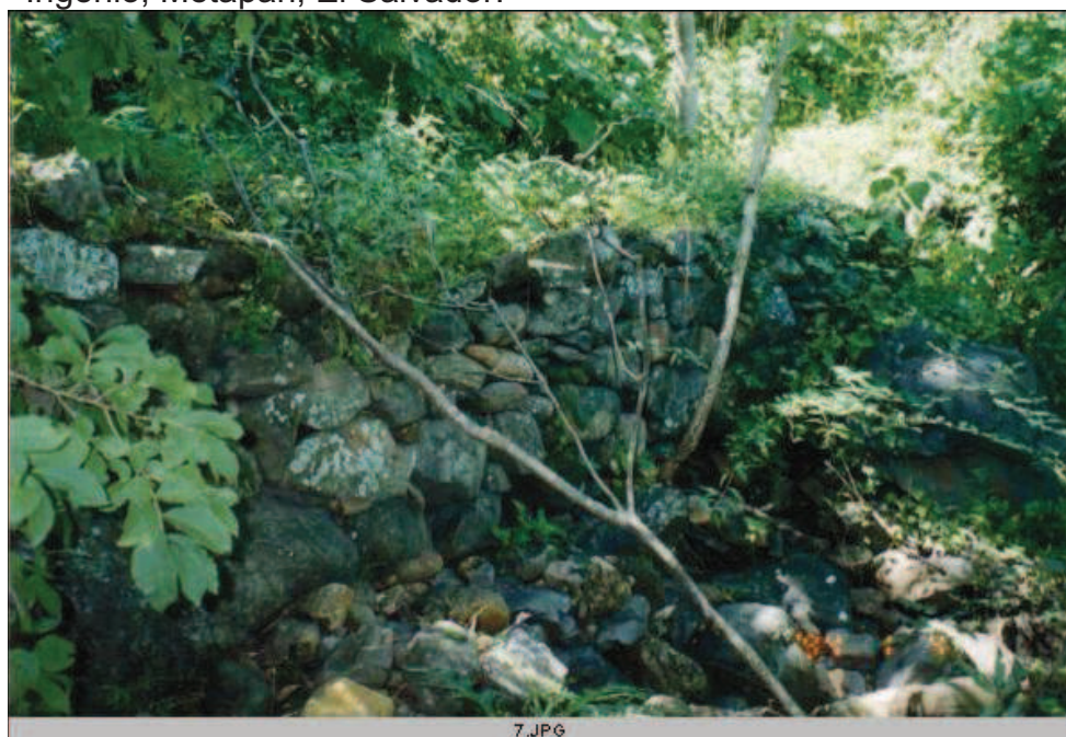
6-A. dique de Retención semidestruído por actividad antropogénica
