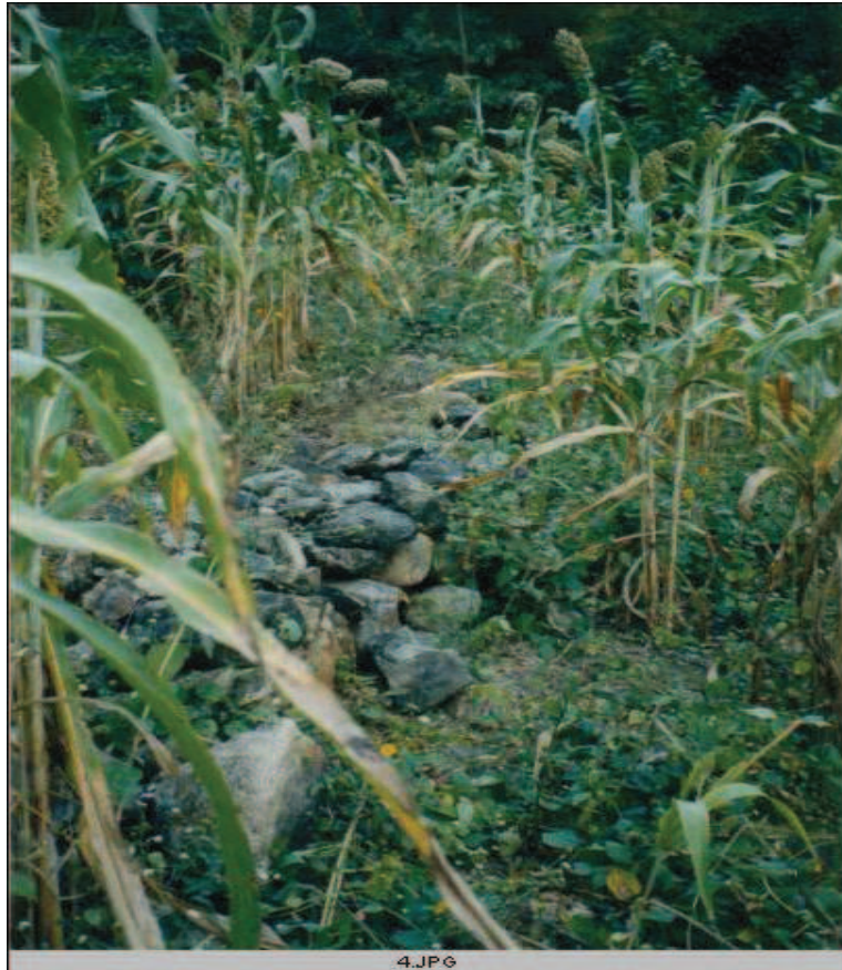
4.JPG 6-D. Barrera de piedra existente del proyecto.
