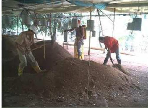
3. Altura de la pila de 1.50 mt a 1.60 mt.
