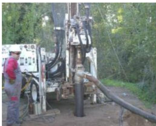
Figura 1. Torre de extracción de núcleos
