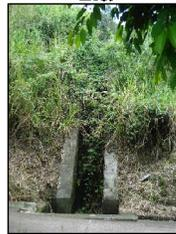
Foto 3y4. Descarga de agua en talud hacia canaleta en 50 av nte.
