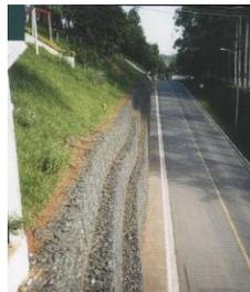
resistencia a la compresión y elevada tensión de tracción que es soportada por la malla (con baja deformación), una malla hexagonal de doble torsión que es resistente debido a la geometría de la malla y la presencia del acero y de las piedras durables, a causa del revestimiento de los alambres con Galfan (liga Zinc/Aluminio), y cuando sea necesario, con revestimiento plástico adicional.
