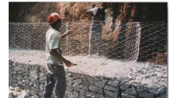
Puede ser usado para el relleno canto rodado o piedra partida. El llenado puede ser realizado manualmente o con el auxilio de equipo de obra.
