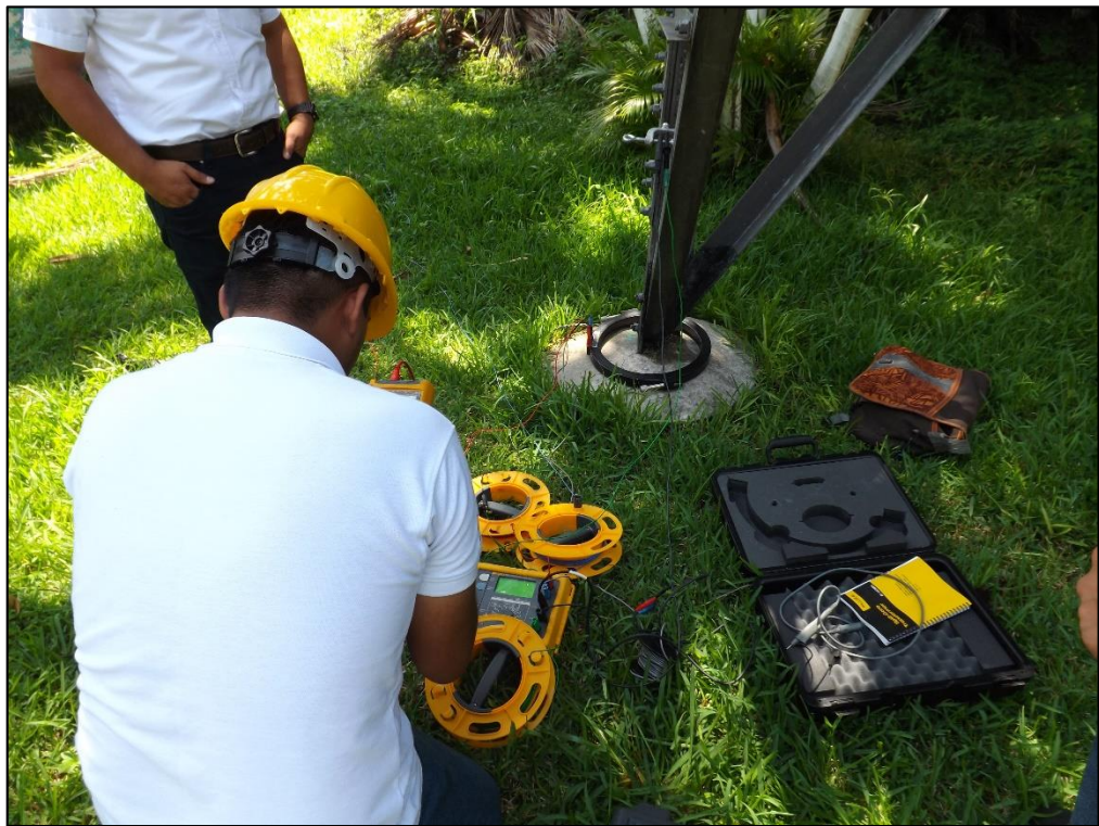
Figura J.14 Medición de resistencia de puesta a tierra en torres de transmisión en subestación 1
