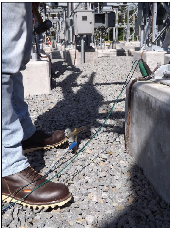
Figura J.15: Electrodo colocado simulando un pie de un operador dentro de la subestación 2
