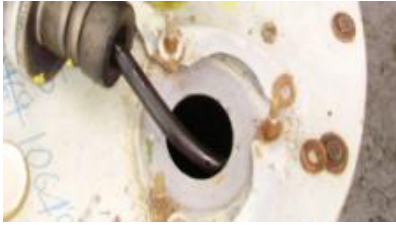
Figura A1.2: aislador retirado.
