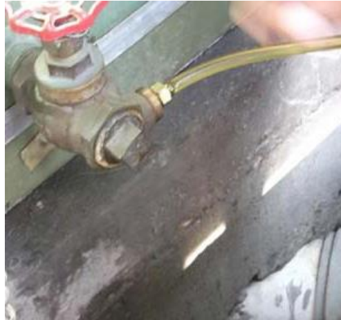
Figura A1.1: válvula de transformador de potencia
