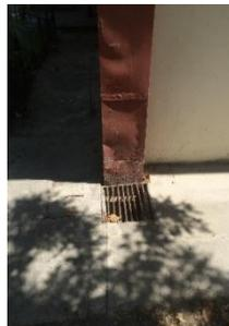
Foto de descargas de aguas lluvias sobre fachada sur
