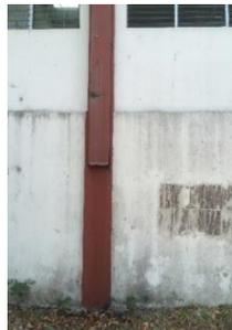
Foto de descargas de aguas lluvias sobre fachada norte
