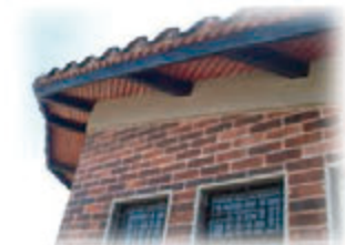
Materiales utilizados en el edificio de la Parvularia San Jacinto.
