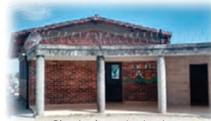
Circulaciones techadas. Fotografía: visitas de campo
