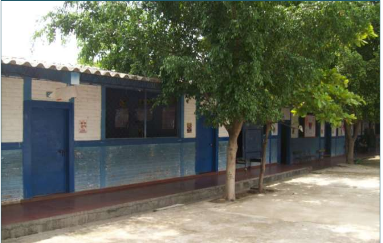
Fig.2.- Instalaciones del C.E. República de Venezuela
