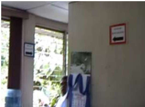
Figura 27. Señales de ruta de evacuación con diferente color en la misma área.
