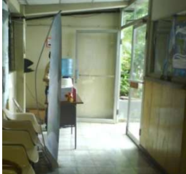
Figura 29. Entrada al primer nivel del edificio obstruida.
