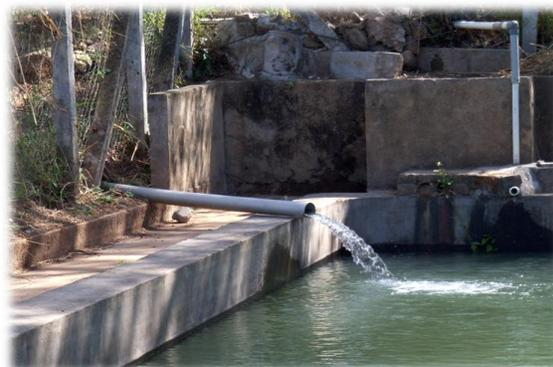
*Figura 33. Tubería de entrada de agua para tanque de riego, cantón El Carmen, San Ignacio, Chalatenango.*
