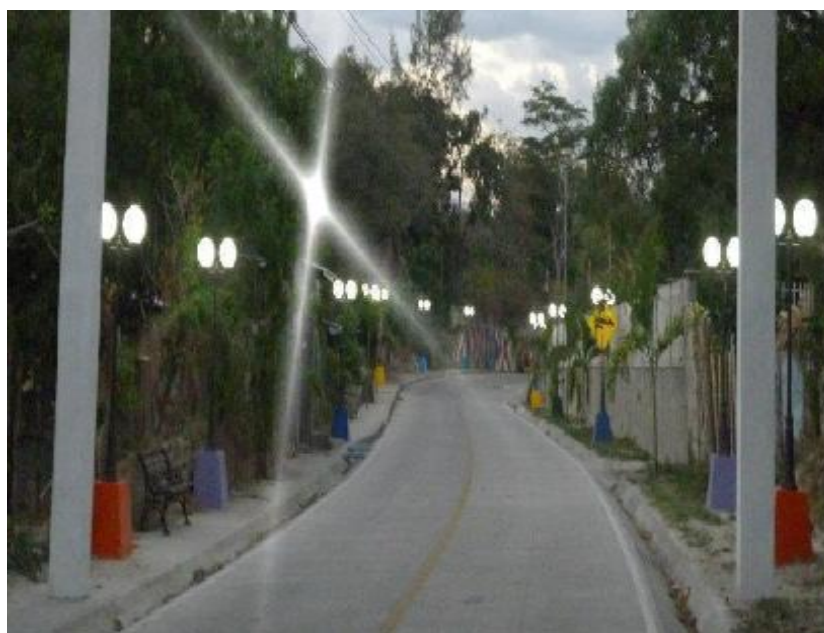
FIGURA N0.5: Reparación y ornamentación de carretera entrada a San Juan Tepezontes.
