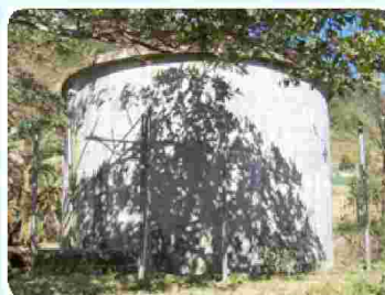
Tanque de almacenamiento de agua para consumo
