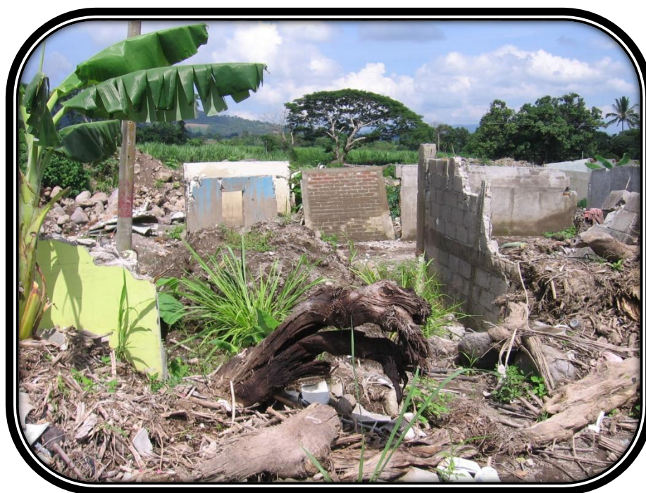
FOTOGRAFIA 6: ZONA TOTALMENTE DESTRUIDA CONOCIDA COMO ZONA ROJA O INHABITABLE
