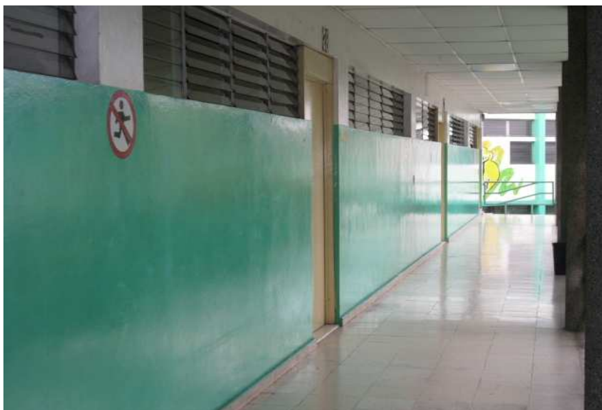
Señalización en pasillos de aulas del segundo nivel
