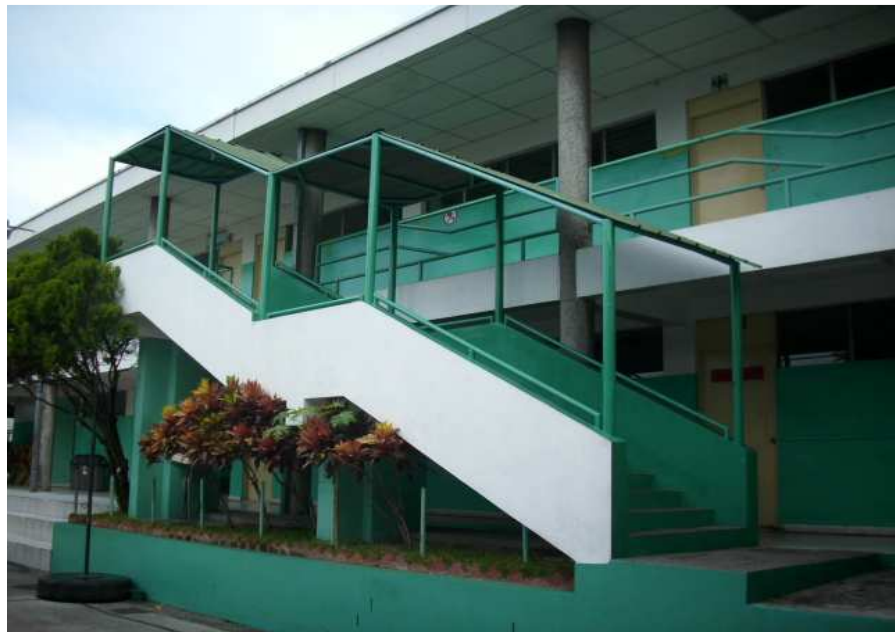
Escaleras de acceso aulas del segundo nivel
