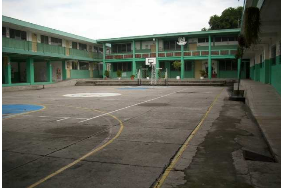
Vista panorámica de instalaciones de aulas y cancha No. 1
