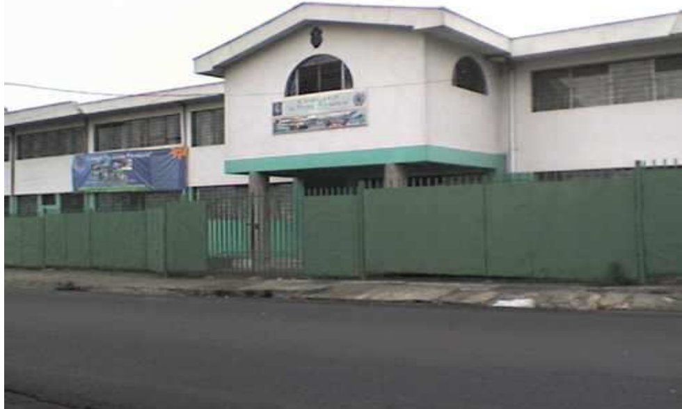
Vista frontal del edificio que es utilizado para la educación de tercer ciclo y bachillerato
