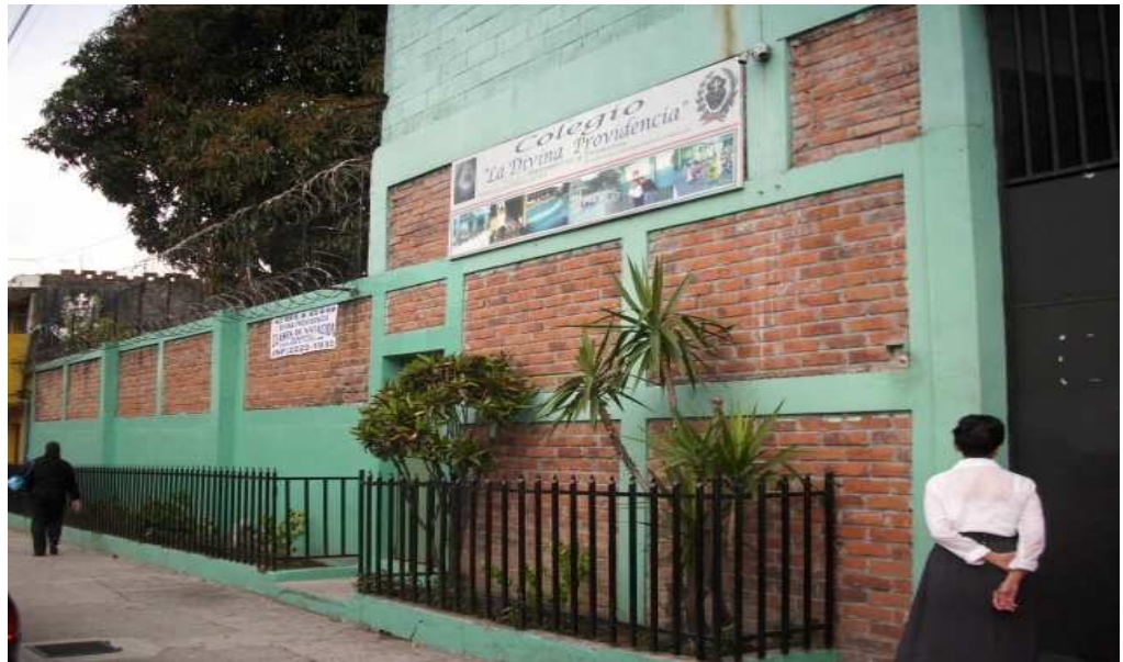
Fachada del edificio de dos plantas donde funciona parvularia hasta segundo ciclo.
