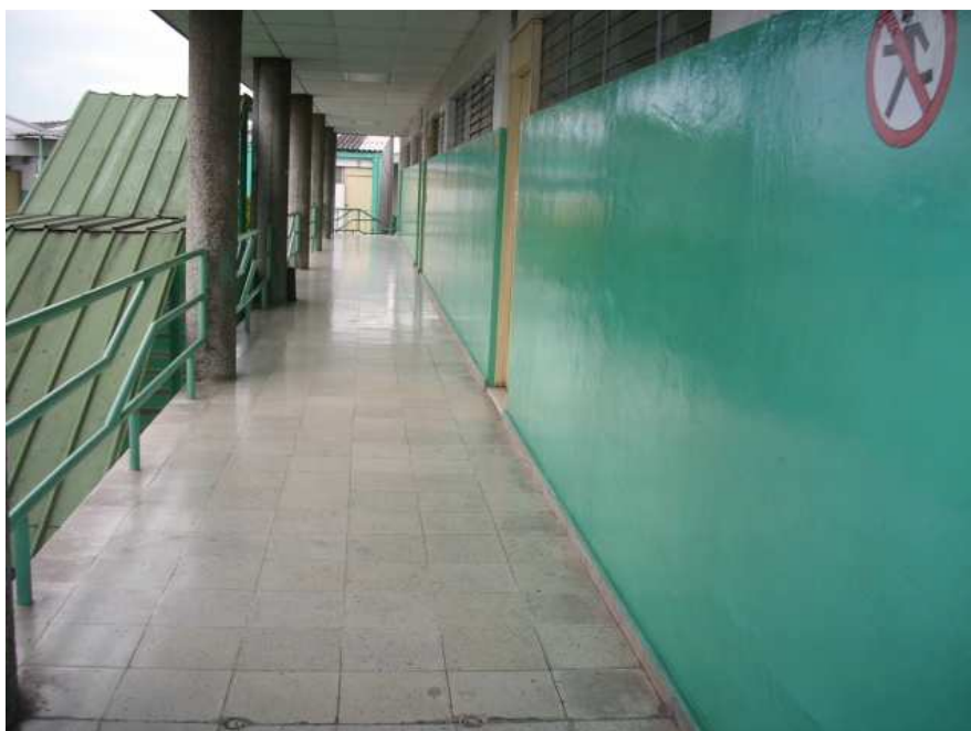
Corredores de acceso a aulas del segundo nivel
