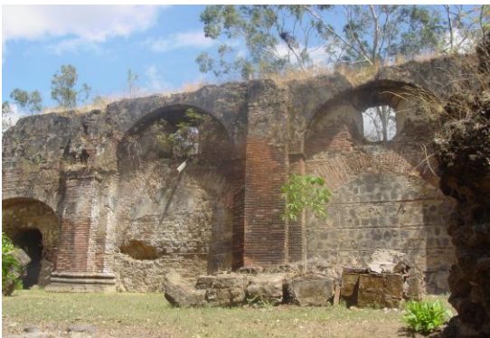
Vista de muros perimetrales en los que se observa el sistema constructivo de calicanto, arcos medio punto.
