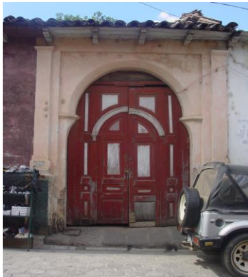
Detalle de zaguán enmarcado por pilastras, alto y bajo relieve, vano de arco de herradura y puertas entabladas de madera.
