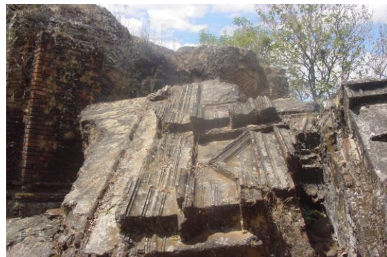
Vista de escombros que podrían haber formado parte de la fachada en la que se observa parte de frontón y cornisa.
