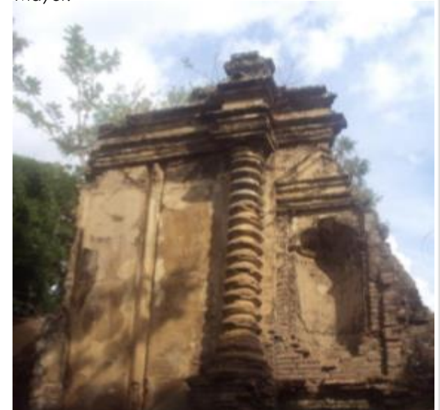
Foto: 2 Iglesia Colonial en Ruinas . La foto muestra lo que queda de la Fachada Principal.
