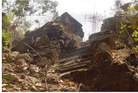
Vista de la sección transversal de fachada aun en pie, en la cual se observa parte del frontón, columnas salomónicas, y cornisa.
