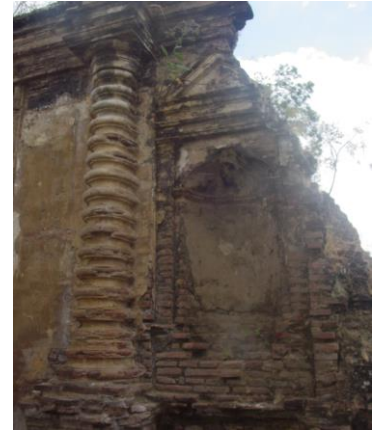
Vista de una parte de la fachada en la que se observa la columna de sección circular de estilo salomónica, cornisa y nicho coronado por frontón.
