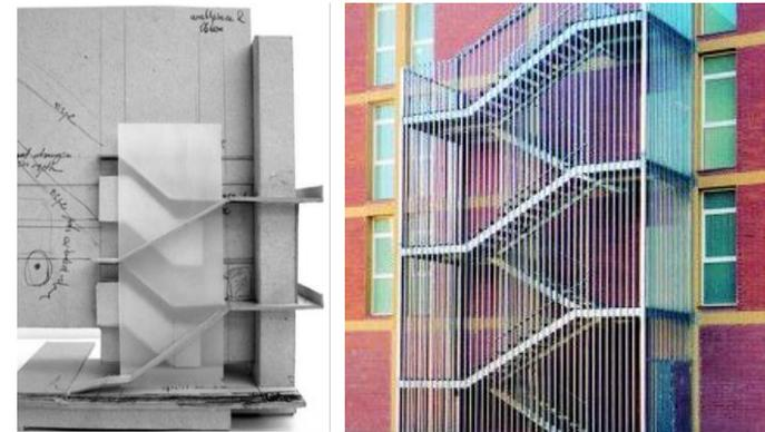
*Ilustración 82:* Protección cubo escaleras de emergencia.
