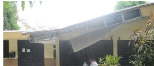
Ilustración 27: Luminaria y cielo falso en mal estado
