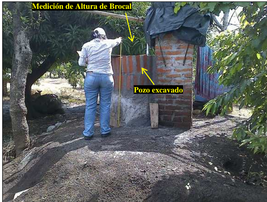
Figura 3.1. Pozo identificado como CSE10, localizado sobre la Carretera del Litoral, a la altura del desvío hacia La Hachadura, Cantón y Caserío La Hachadura, Municipio de San Francisco Menéndez.
