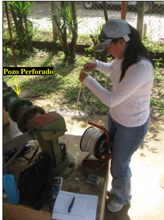
Figura 3.2. Pozo perforado identificado como CSP04, propiedad de ASEPROS, municipio de Cara Sucia. Medición del nivel estático, mediante el empleo de sonda para medición de niveles Fecha: 31 de enero de 2013.
