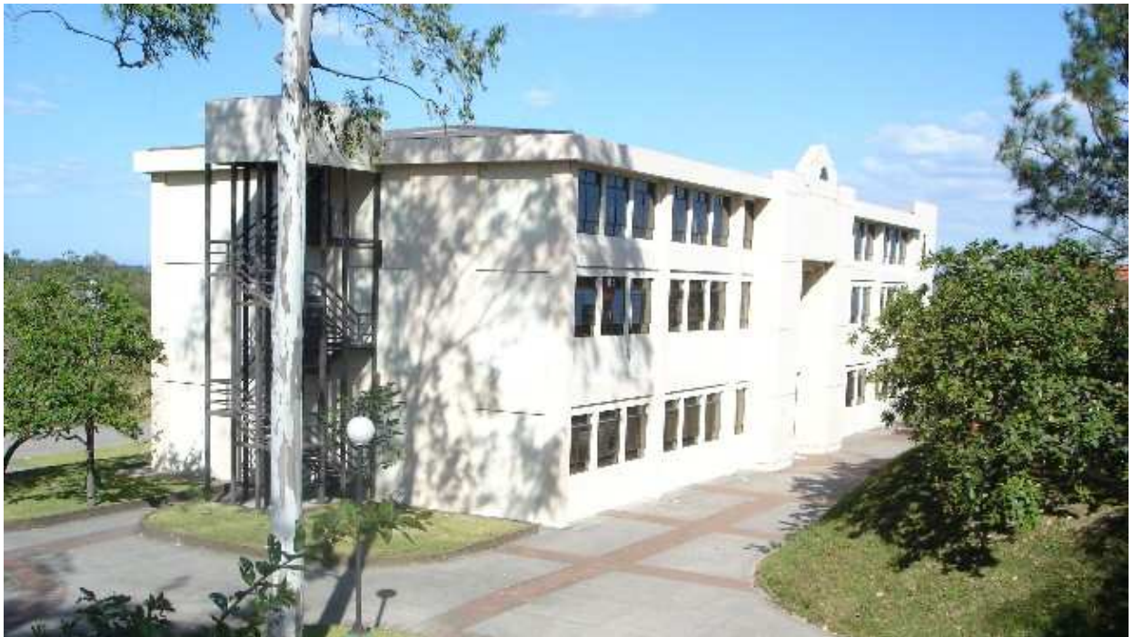
Fotografía 13.1. Vista poniente del edificio de Ingeniería en Sistemas e Ingeniería.
