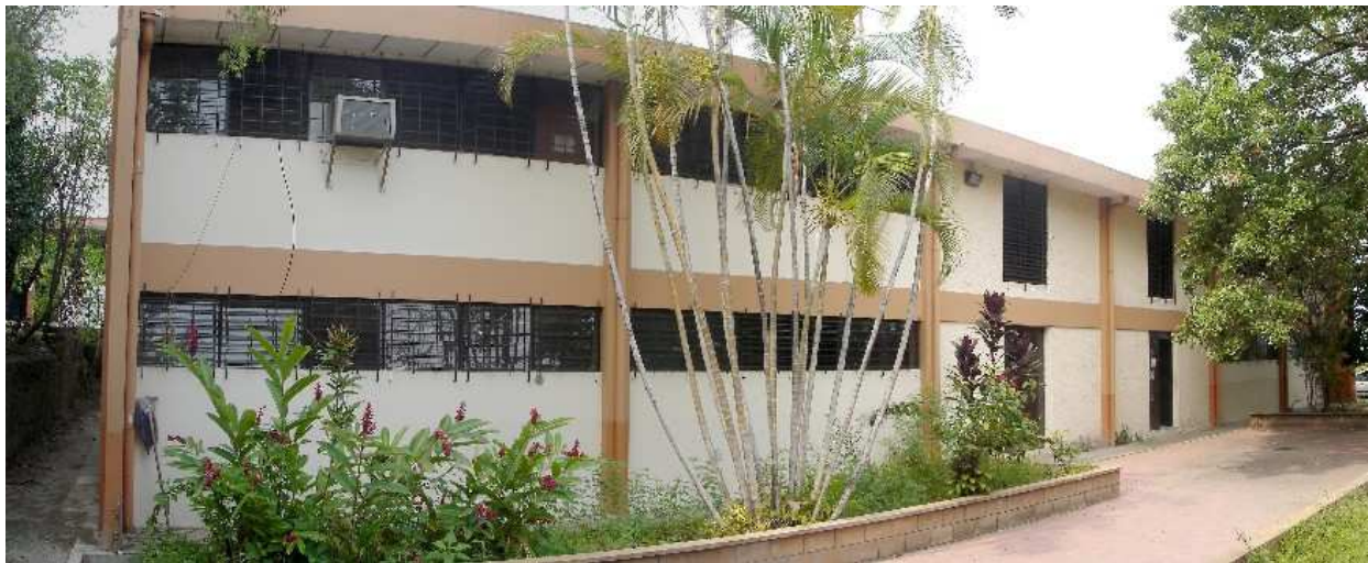
Fotografía 13.6. Vista del Edificio de la escuela de Ingeniería Eléctrica.
