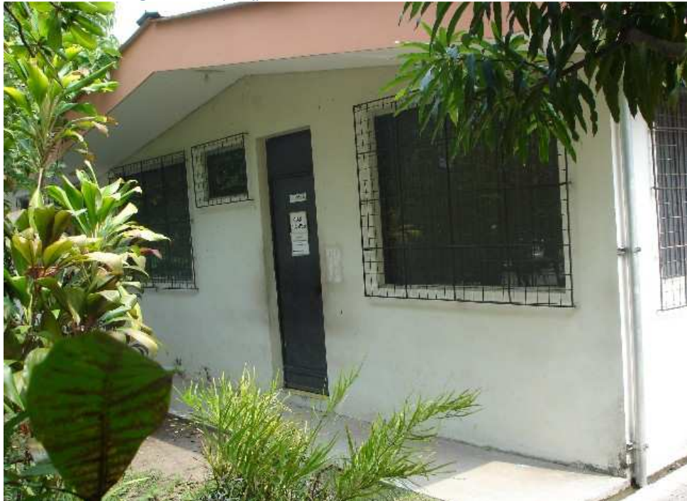
Fotografía 13.4. Vista Centro de Investigaciones y Aplicaciones Nucleares (CIAN), área de laboratorios.
