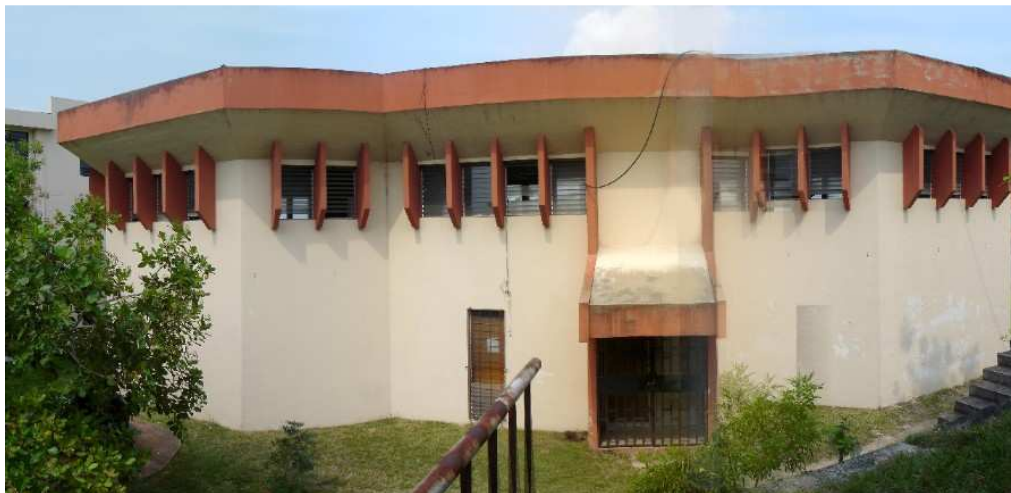
Fotografía 13.7. Vista del Edificio de Potencia.
