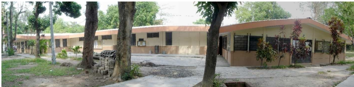
Fotografía 13.9. Vista Poniente del Edificio Administrativo y laboratorios de las ciencias Básicas.
