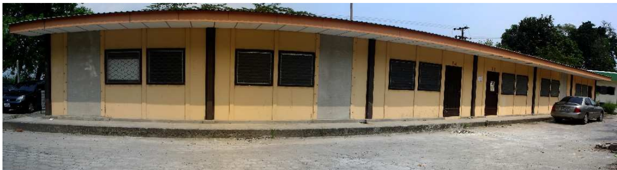
Fotografía 13.5 Vista Centro de Investigaciones y Aplicaciones Nucleares (CIAN), área administrativa.
