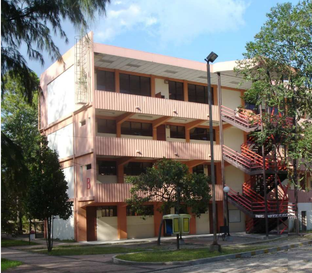
Fotografía 13.12. Vista del Edificio B.
