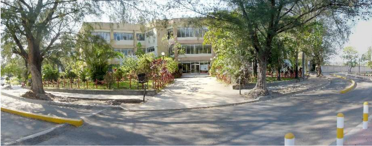
Fotografía 13.16. Edificio de la Biblioteca de las Ingenierías
