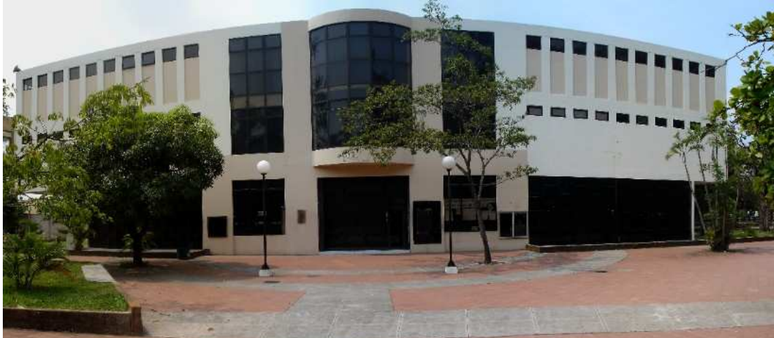
Fotografía 13.15. Administración Académica de la Facultad de Ingeniería y Arquitectura.
