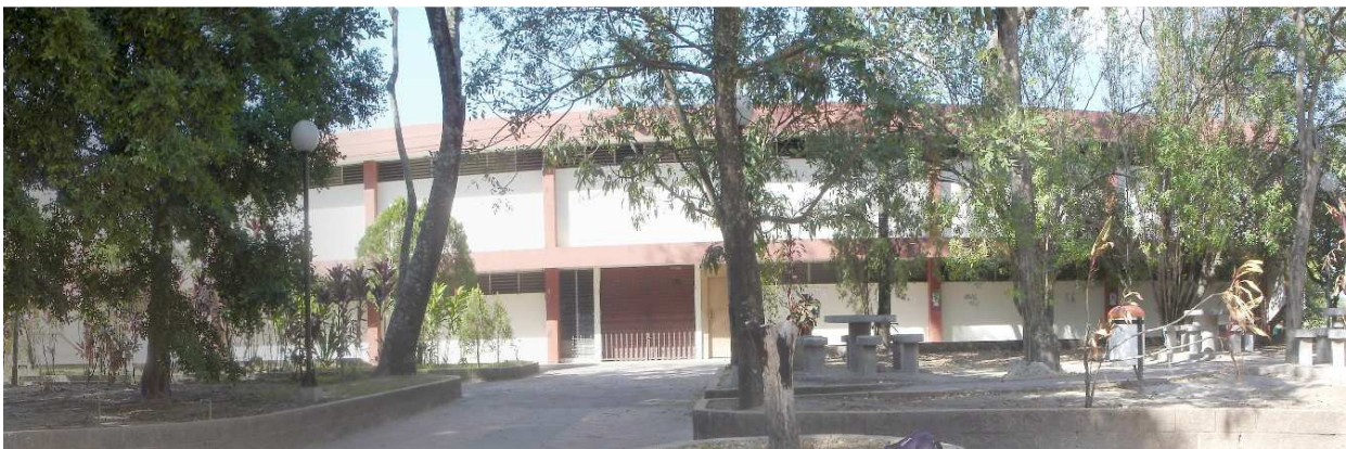
Fotografía 4.10. Vista Sur del Edificio de la Escuela de Ingeniería Civil.
