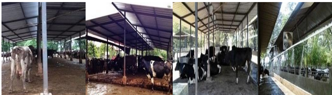
Figura 7. Instalaciones sin sistema de tratamiento para estrés calórico (izquierda) y con tratamiento (derecha)
