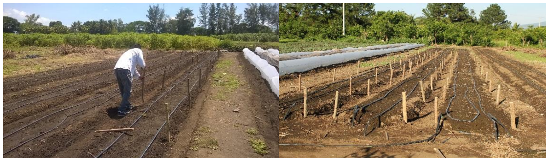
Figura 6. Instalación de sistema de riego y aros metálicos
