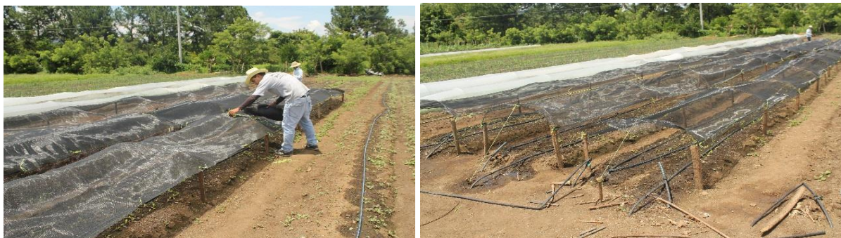
Figura 8. Instalación de sombra
