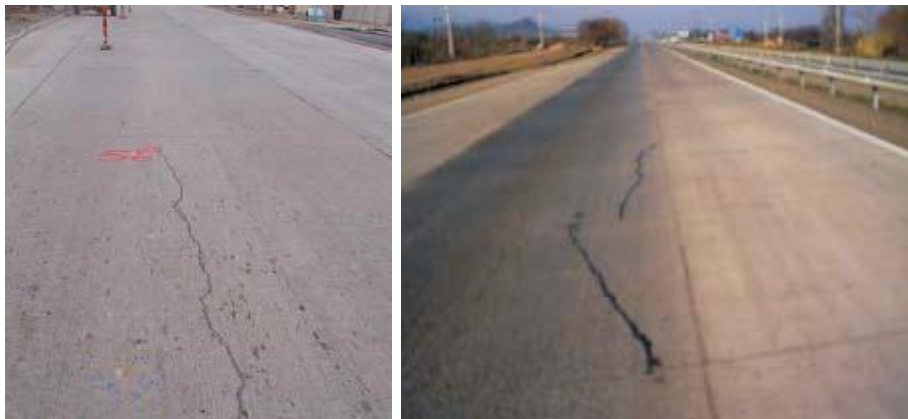
Figura 2.6: Grietas longitudinales
