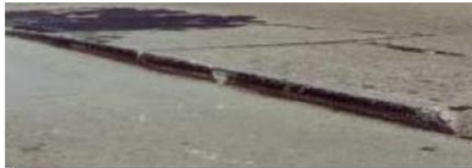
Figura 2.4: Escalonamiento de juntas
