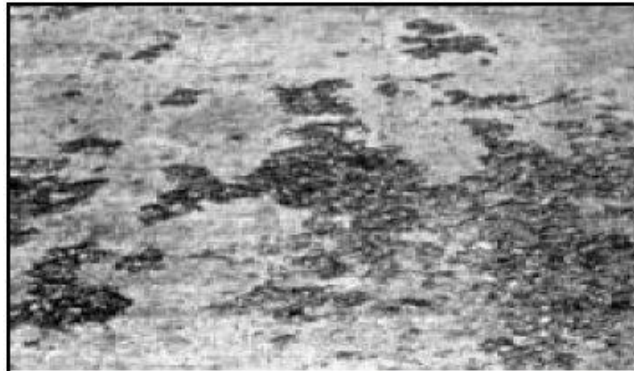
Figura 2.10: Descascaramiento
