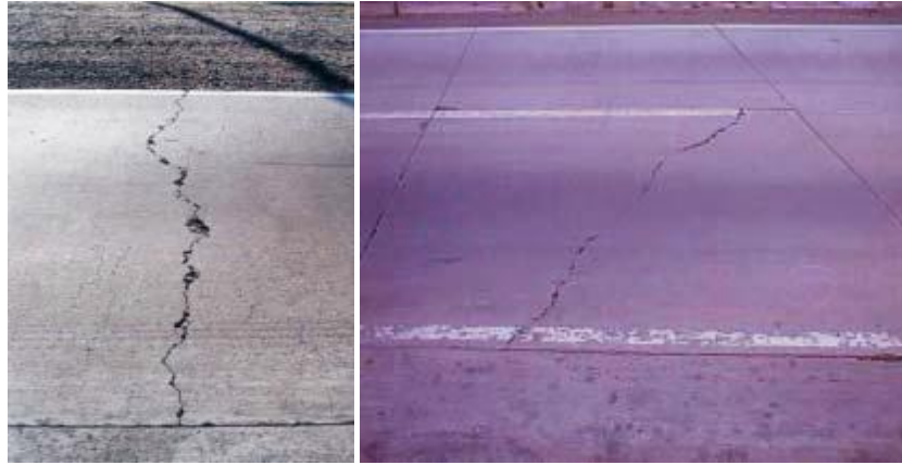
Figura 2.7: Grietas transversales
