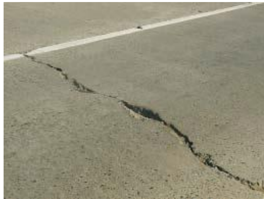
Figura 2.3: Despostillamiento
