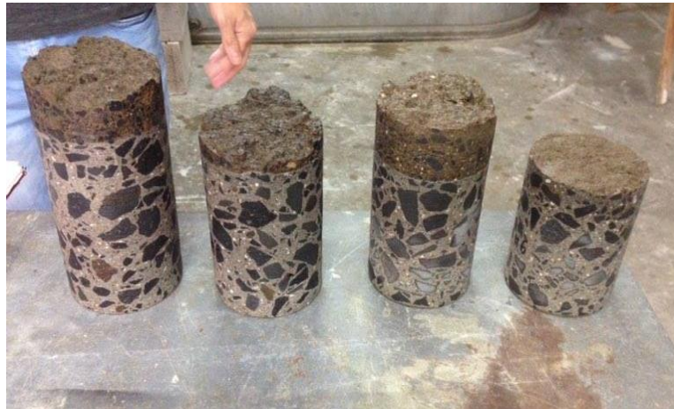
Figura 4.8: Núcleos de concreto de 4" de diámetro, extraídos del pavimento en estudio
