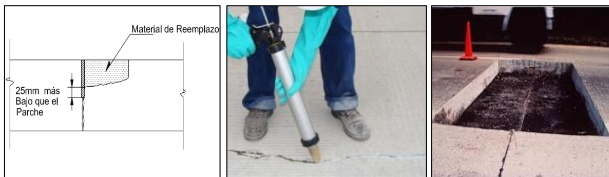
Figura 5.11: Técnicas de reparación de pavimentos rígidos.
